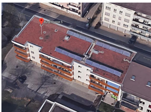
Bürglistrasse 3+5 Liegenschaft mit besten Energiewerten Primärenergieverbrauch = 45.2 kWh/m 2
